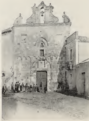
Iglesias - Chiesa di S. ta Chiara (facciata).
